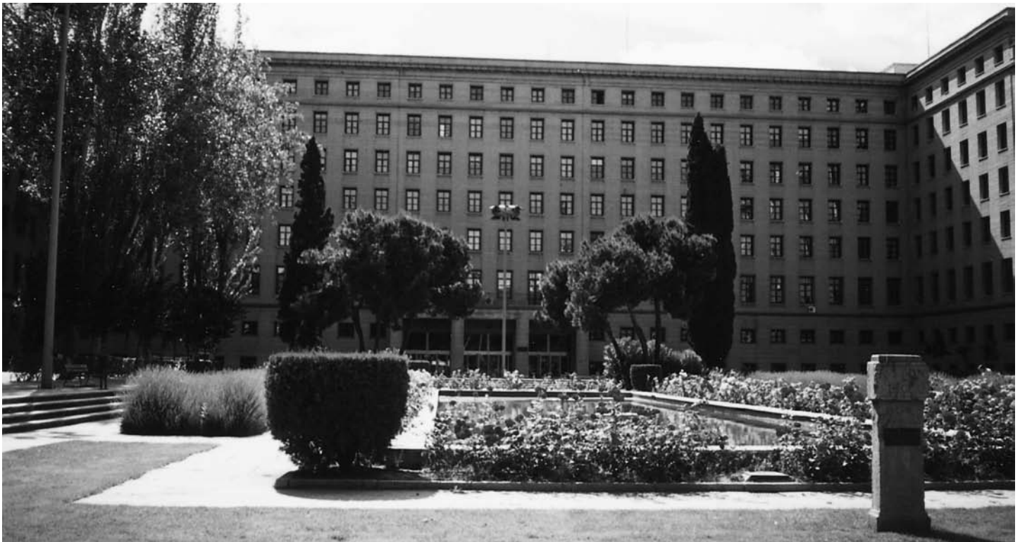
Ministerio de Fomento, a cuya Secretaría de Estado de Infraestructuras se le ha requerido informes, previamente solicitados, sobre demora en los pagos por expropiaciones.
