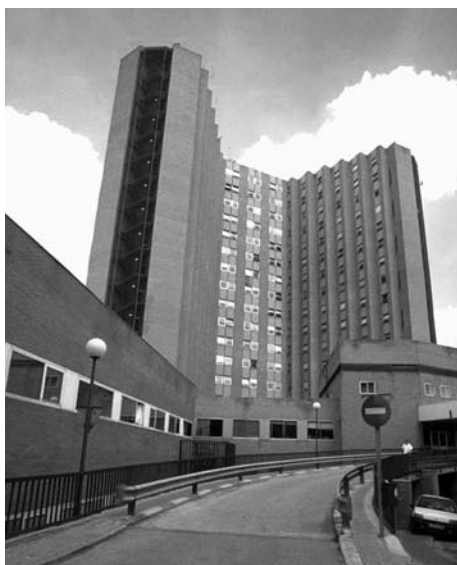
La gestión y funcionamiento de los centros hospitalarios son las causas por las que disminuye la satisfacción de usuarios y pacientes sobre el sistema sanitario en su conjunto. En la foto, el Hospital 12 de Octubre, de Madrid, en cuyas proximidades han comenzado las obras del nuevo edificio que le sustituirá.
