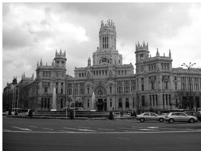
La transformación de Correos y Telégrafos en Sociedad Anónima Estatal ha generado quejas por los traslados de puestos de trabajo. En la foto, el edificio central de Correos, en Madrid.
