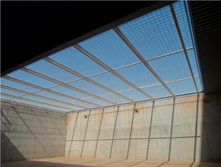
Patio de aislamiento en el CP Las Palmas II
