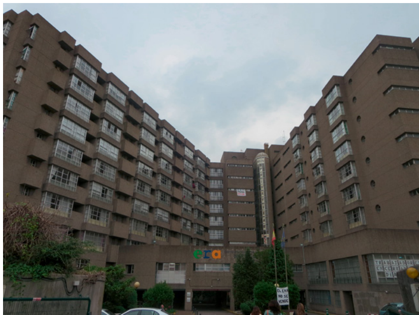
Edificio de la Residencia Mixta Pumarín (Gijón)
